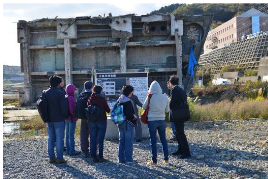
図3-2.4 津波で転倒した建築物の視察 (平成26(2014)年11月)
